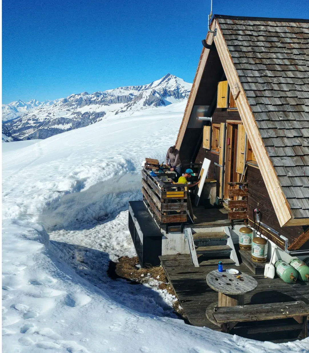
Travaux d'entretien en plein confinement - Claire
